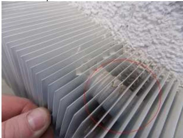
1.2. Закрепить тепловой адаптер при помощи U-образной шпильки М4 и двух гаек М4 параллельно ребрам конвектора:
